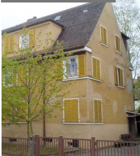
До ремонта с vinylTop
