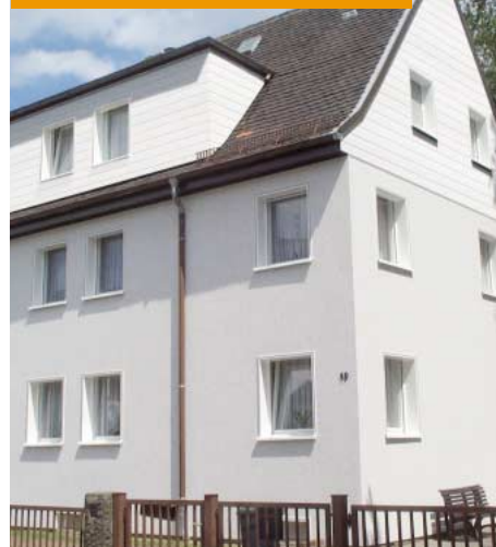
После ремонта с vinylTop
